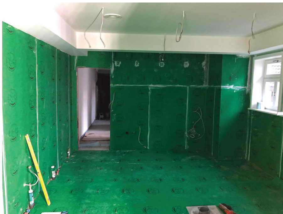
Unter den Abdichtungsbahnen wurde ein Ausgleichs- und Gefälleestrich eingebaut.
